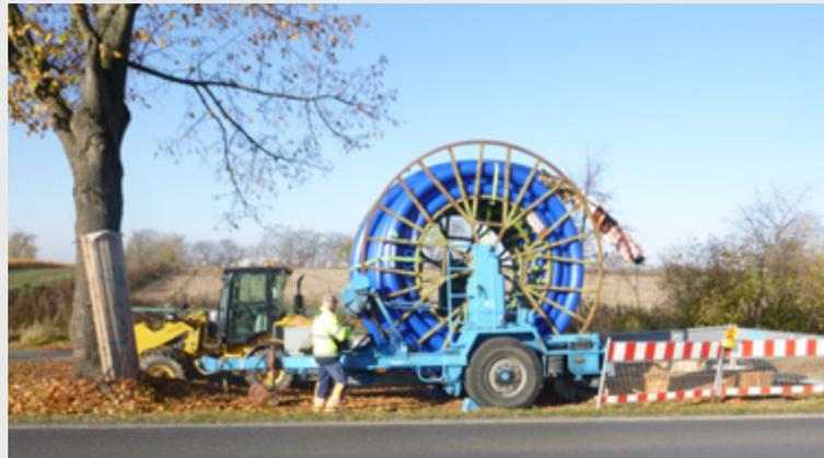
**Bild 11:** Trommel mit aufgewickelten Rohren [1]
