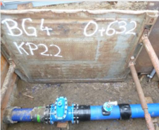
**Bild 10:** Einbau Armaturen, Formteile [1]
